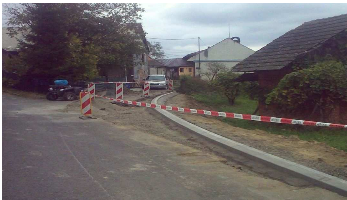
Foto: Oprava komunikace v místní části Drahy
